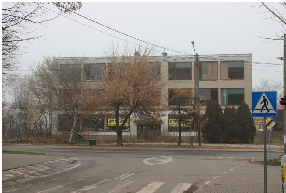
Fot. nr 1. Budynek byłego Pawilonu Handlowego (budynek GS)
