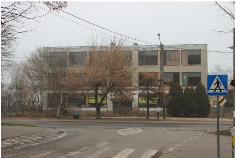
Fotografia nr 1. Budynek byłego Pawilonu Handlowego (budynek GS).
